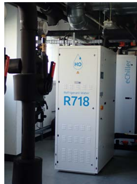
Abb. 3: Bei Siemens in Cham sind seit 2018 zwei eChiller zur Prozesskühlung im Einsatz und punkten in allen Bereichen: Energieeffizienz, Betriebssicherheit, Umweltschutz und CO 2 -Einsparung.
